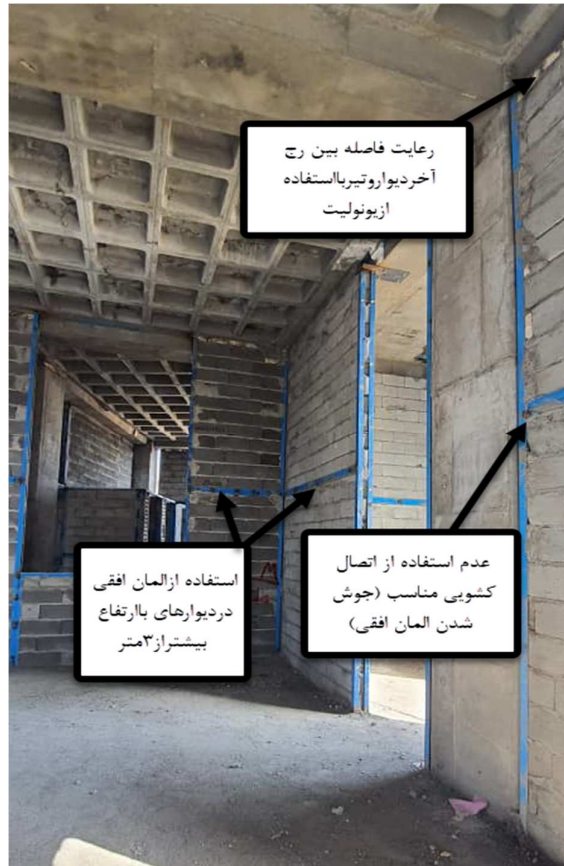
شکل ۴-۱۳ استفاده از وادار افقی بیش تر از ۳.۵ متر
