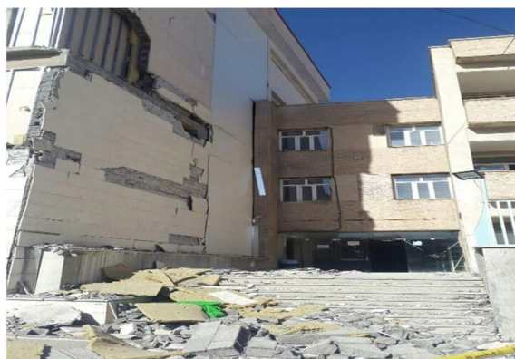
شکل ۴-۳۵ آسیب پذیری زیاد دیوارهای محیطی به دلیل تغییر مکان نسبی طبقه
