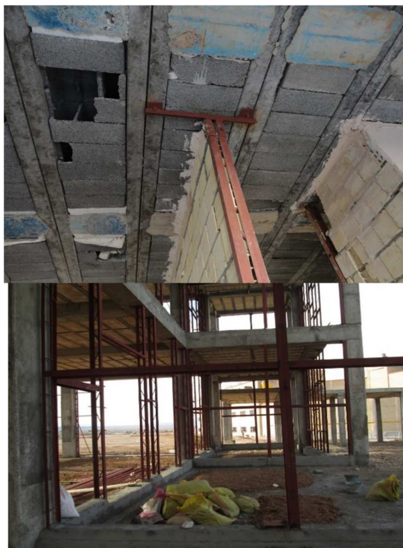
شکل ۴-۲۲ دیوارهای محیطی با مهاربندی مناسب
