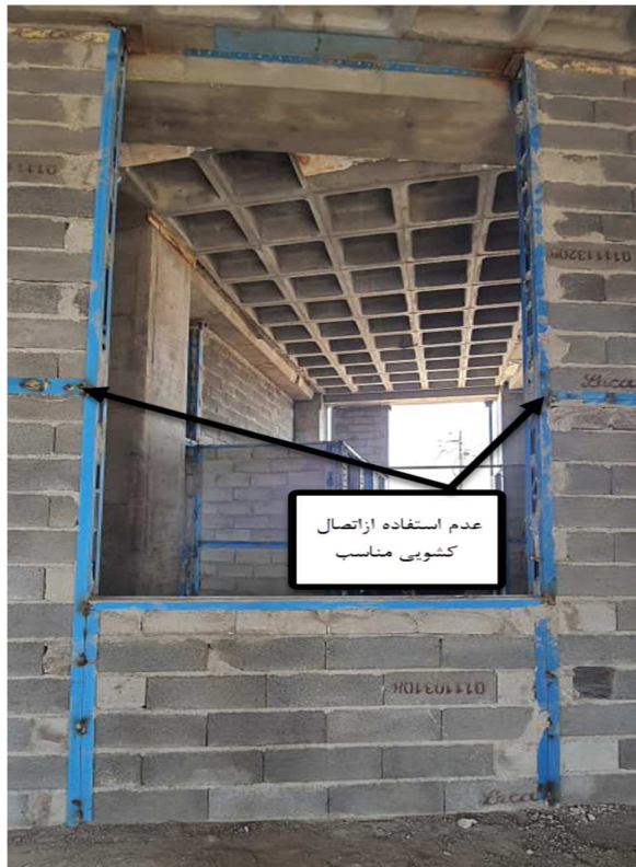
شکل ۴-۱۰ عدم استفاده از اتصال کشویی برای مهار وادار افقی
