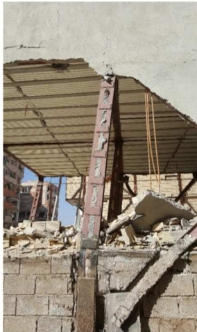
شکل ۴-۱ میان قاب منجر به ایجاد ستون کوتاه در سازه شده است.
