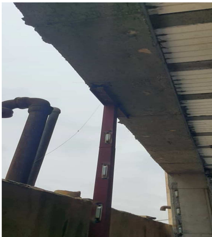
شکل ۴-۳۶ نمونه نبشی کشی مناسب
