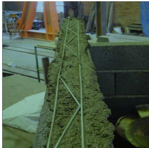
شکل ۳-۲۱ نمونه میلگردبستر خرپایی اجراشده
