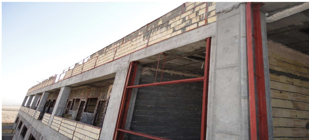
شکل ۴-۲۶ گرفتن آویز میلگرد یا سپری در وسط نعل درگاه پنجره ها و یا درب ها
