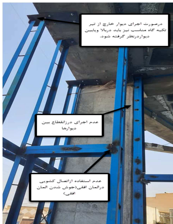
شکل ۴-۱۵ اجرای دیوار خارج از تیر
