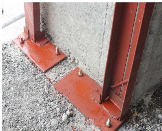
شکل ۴-۳ نمونه اتصالات وال پست به کف
