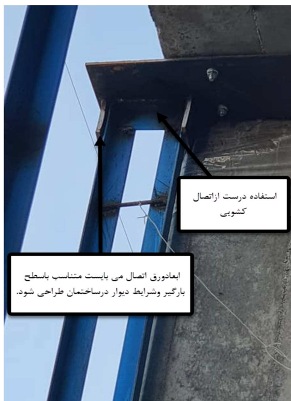
شکل ۴-۱۶ استفاده از اتصال کشویی متناسب با طراحی
