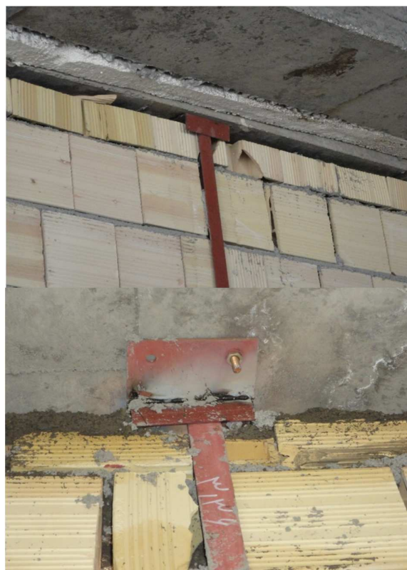
شکل ۳۱-۴ نمونه اتصالات وال پست به سقف
