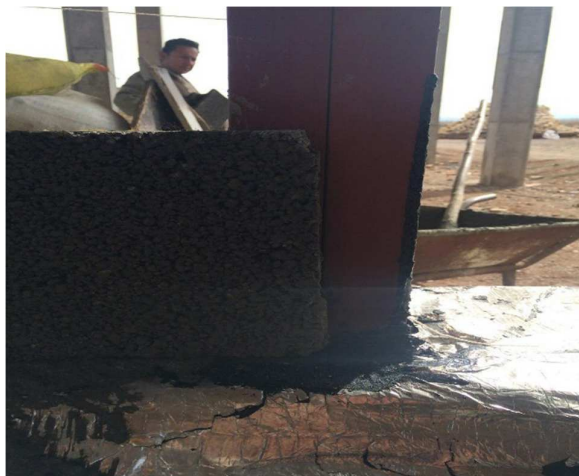
۳۰-۴ روش اصلاحی و ابتکاری برای جلوگیری از ترک شکل
