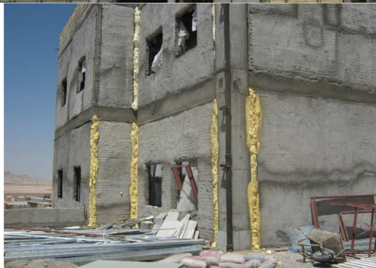
شکل ۴-۲۸ پرکردن درزها با مصالح انعطاف پذیر
