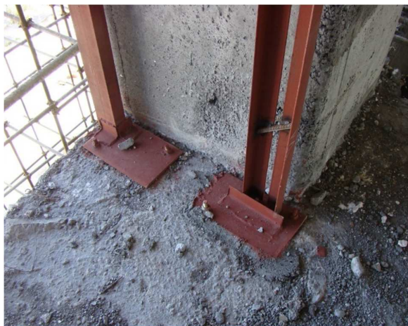
شکل ۴-۳ نمونه اتصال وادار قائم
