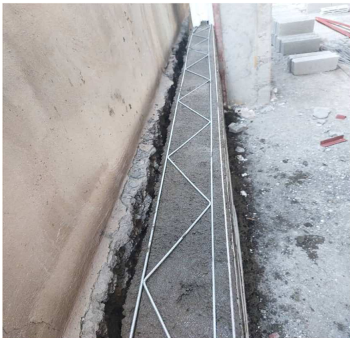
شکل ۳-۲۱ نمونه میلگردبستر خرپایی اجراشده
