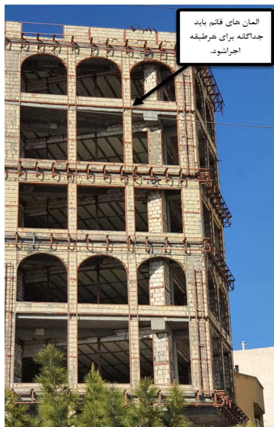
شکل ۴-۲۰ پیوستگی نما و دیوار های اجرا شده در طبقات
