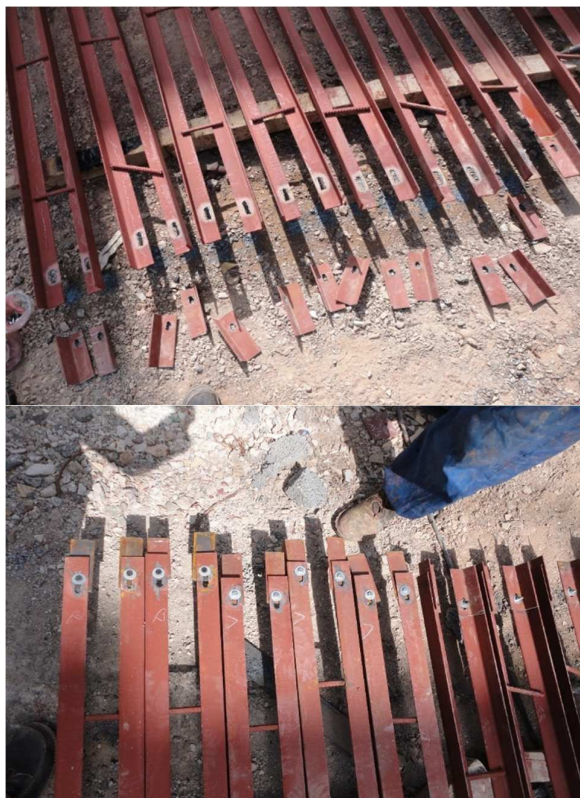
شکل ۴-۲۵ آماده سازی اتصال لوبیایی نبشی ها و سپری هایی که از لغزش آزادانه درون صفحه ای برخوردار است
