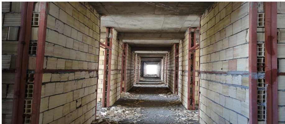
شکل ۴-۲۳ نمای کلی از مهار دیوارها بصورت عمودی و افقی با استفاده از نبشی و سپری جهت مهار خارج از صفحه
