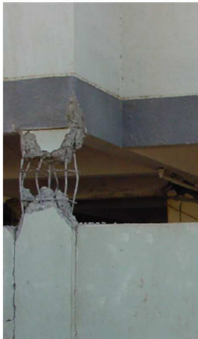
شکل ۳-۱ امکان تغییر مرکز جرم سازه در صورت مشارکت میان قاب ها
