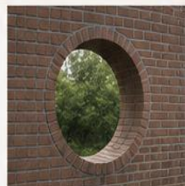
گشودگی در دیوار
