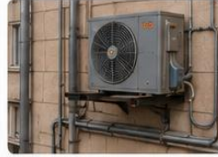
جداجویاری با پنجره ها و فضاهای مسکونی و بدون صدابندی مناسب
