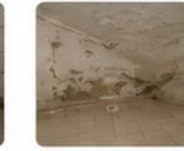
عدم بخاربندی سقف
