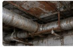
استفاده از مصالح نامناسب و نصب غیر اصولی
