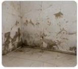
عدم بخاربندی دیوارها
