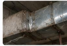
استفاده از مصالح نامناسب و نصب غیر اصولی
