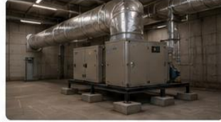
قرارگیری در فضای باز یا موتورخانه با تهویه مناسب و عایق صوتی
