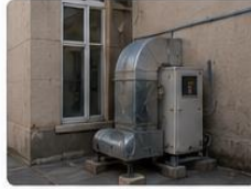
جداجویاری با پنجره ها و فضاهای مسکونی و بدون صدابندی مناسب
